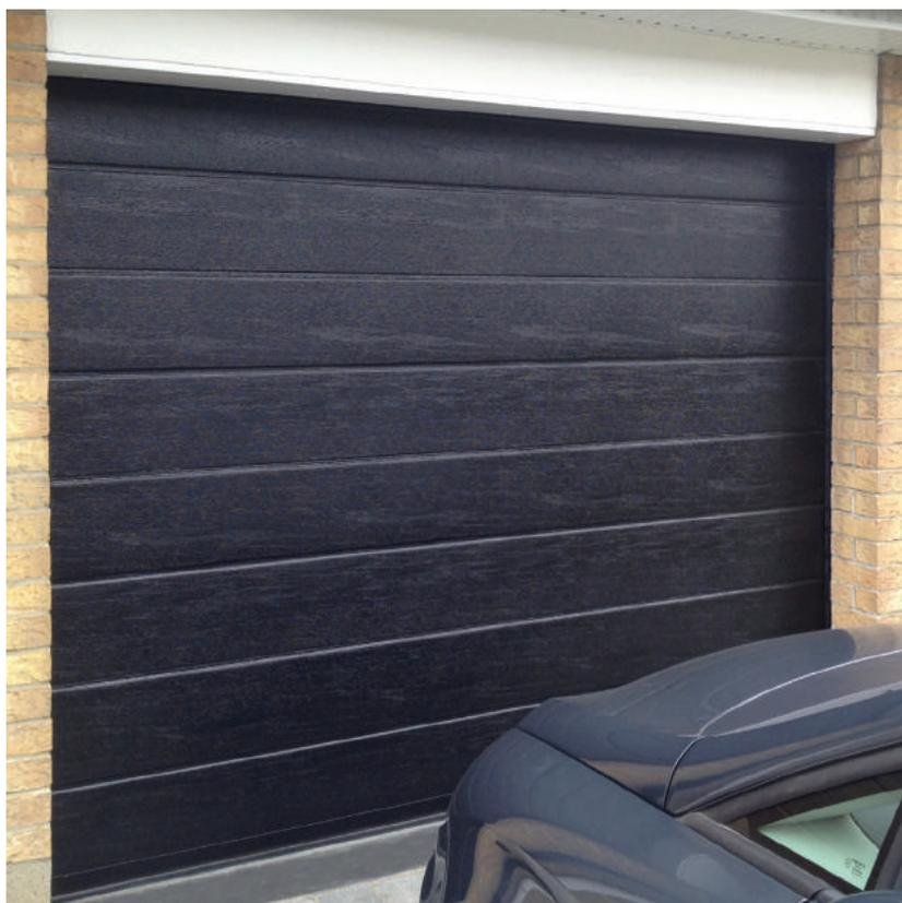
EN HAUT Porte à refoulement plafond micro-rainurée lisse option laquage. À DROITE Porte à refoulement plafond mono-rainurée veinée bois option laquage.
