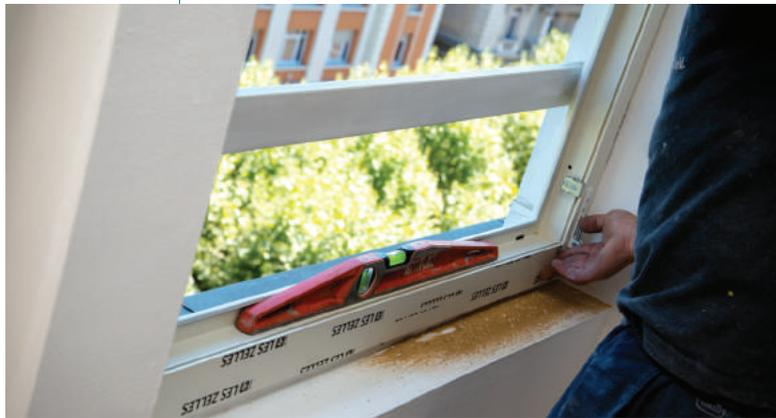
Perçage du dormant par vis à double hélice.
